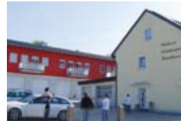
Der Dachs versorgt Bäckerei und Wohngebäude mit Wärme und Strom
