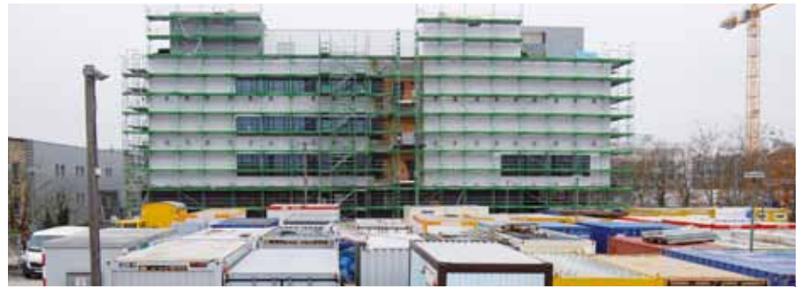
Auf 14.600 Quadratmetern Hauptnutzfläche entsteht bis Herbst 2013 der Neubau des Klinikums Großhadern. Vom ihrem Container aus hat die Bachner-Bauleitung das Projekt im Blick.
