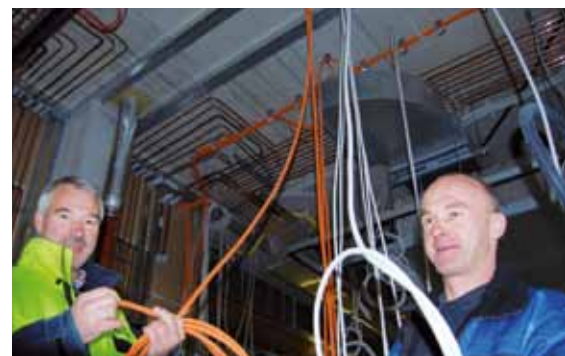
Auf der Baustelle geraten die Obermonteure Jörg Werner (l.) und Jens Hillmann ins Schwärmen: „Tolle Verkabelung!“ loben sie die Teams.
