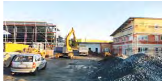
Die beiden Gewerbehallen werden in Zukunft u.a. von einem LED-Systemanbieter genutzt.
