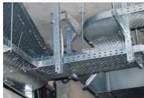
Mitunter war der Trassenbau etwas kompliziert.
