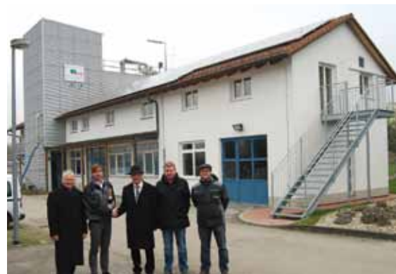
Bürgermeister Reiser (mitte) freut sich über die verminderten Stromkosten des Klärwerkes
