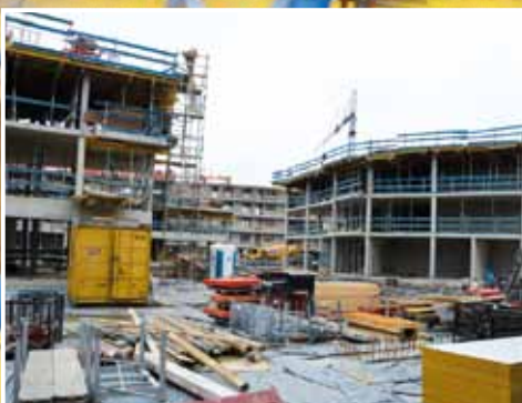
Baufortschritt Anfang November 2014
