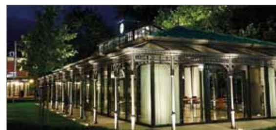
Große Glasflächen machen die temperierte Raumlüftung der Orangerie notwendig.
