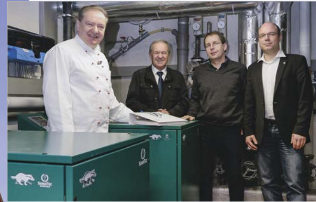
(v.l.) Betreiber Sepp Mayer, Günther Meyer von Erdgas Schwaben, Fachmonteur Thomas Koch und Harald Stark stehen zum Dachs.
