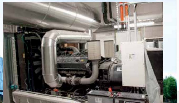
Auch der Anschluss des Dieselgenerators zur Notstromversorgung war eine Aufgabe.
