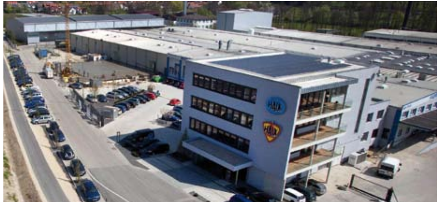
Bachner übernahm für alle drei Bauabschnitte des Haix Unternehmenssitzes in Mainburg die Elektroarbeiten.
