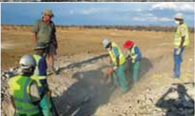
Massiver Granit erschwerte die Bodenarbeiten für die Verkabelung
