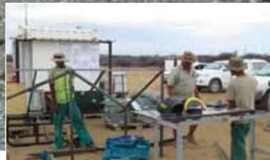
Bau eines großen Siebes, um Erdaushub von Steinen trennen zu können.
