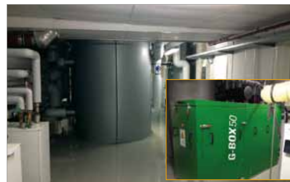
Die Heizzentrale wurde in nur sechs Wochen aufgebaut und war sofort einsatzbereit.
