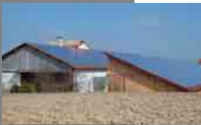
Die PV-Anlage mit 80,5 kWp.
