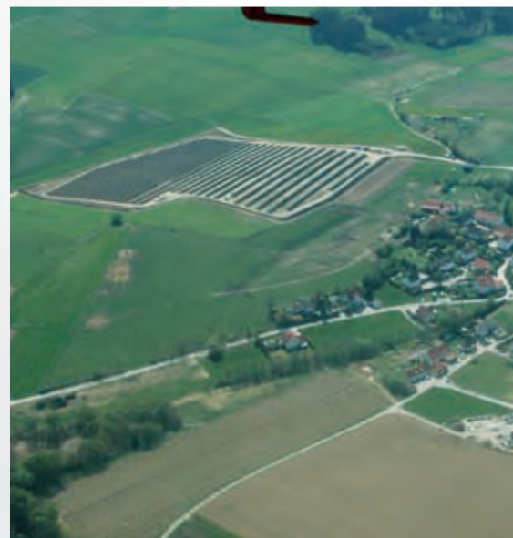
Strom für 675 Haushalte: Die Freiflächenanlage bringt eine starke Leistung
