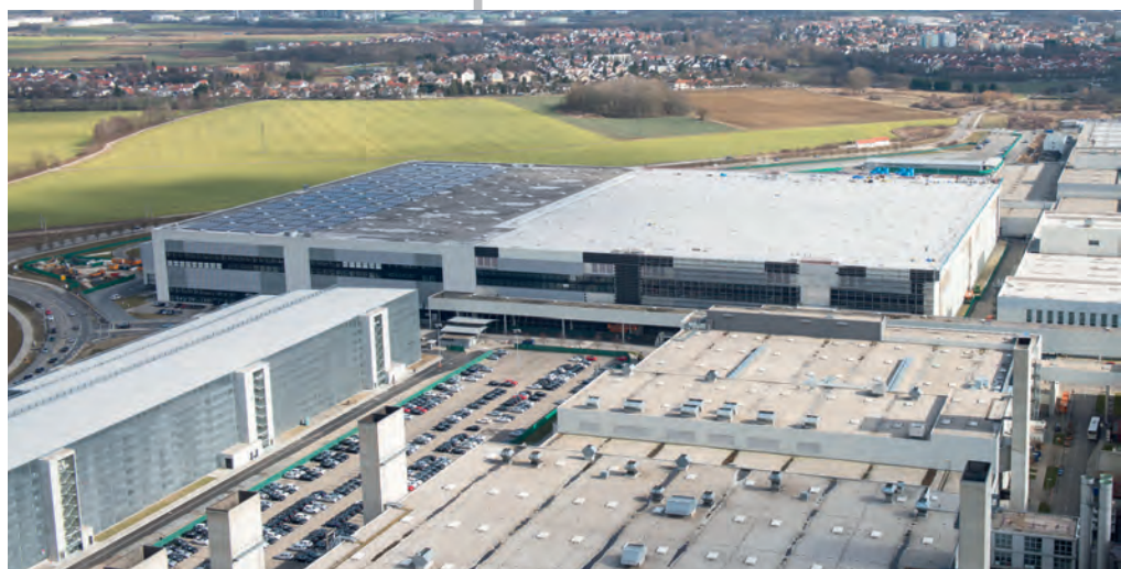
Die Großbaustelle N60 aus der Vogelperspektive
