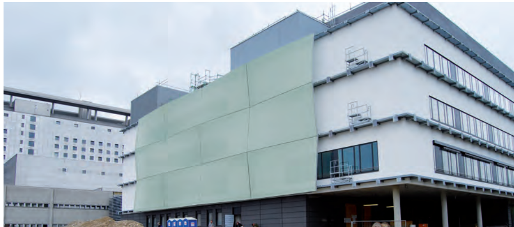
Die Fassade des OP-Zentrums wird ringsum mit einem wellenförmigen Segel bespannt. Die ersten Elemente lassen die fertiggestellte Ansicht erahnen.
