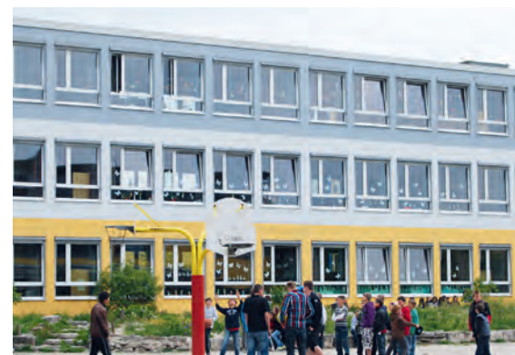
Die Mittelschule verbraucht den selbst erzeugten KWK-Strom komplett selbst.
