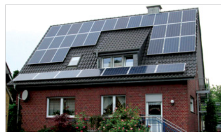
Photovoltaik aus dem Volthaus sieht auch mit Klinkerfassade gut aus.
