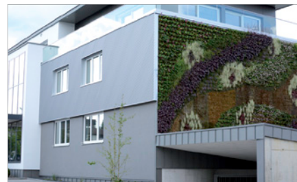
Ein „Hingucker“: Die begrünte Ostfassade mit Bewässerung aus der Regenwasser-Zisterne.
