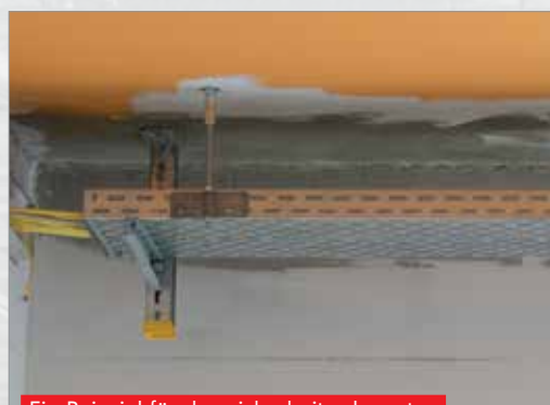
Ein Beispiel für den sicherheitsrelevanten Trassenbau nach Vorgaben der Muster-Leitungsanlagen-Richtlinie.
